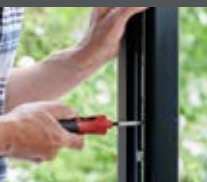
Atornillado eléctrico rápido
